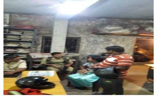
मानगो थाना, जमशेदपुर का जर्जर कार्यालय (30/10/2018)।
